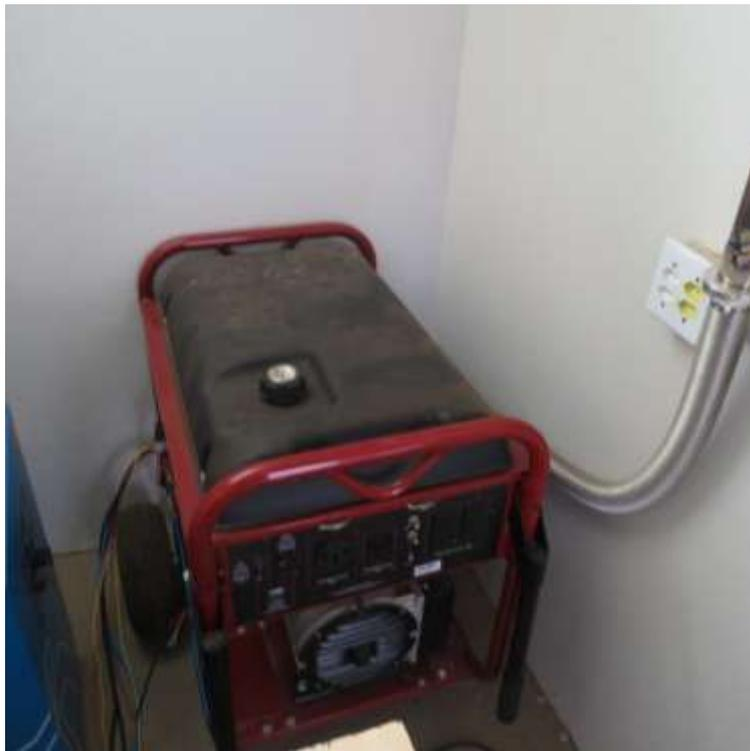
Figura 5 -Gerador a gasolina para manutenção do sistema em operação durante falta de energia prolongada
