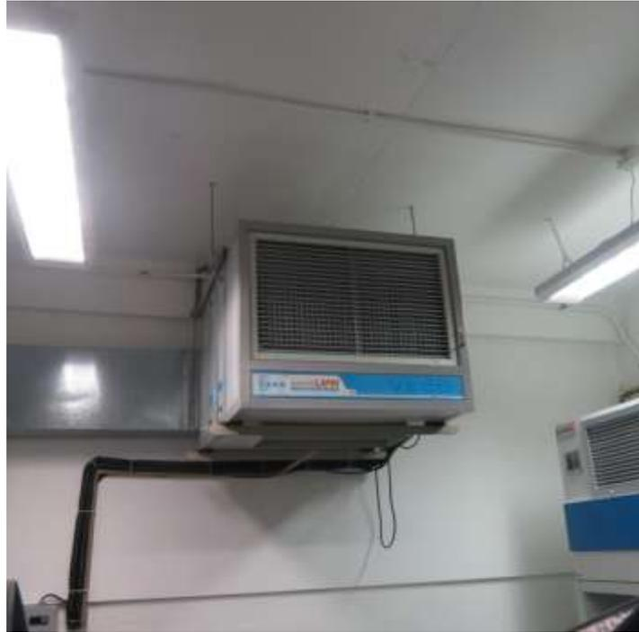
Figura 2 - Sistema de purificação e climatização de ar do laboratório (sala classe 10.000)
